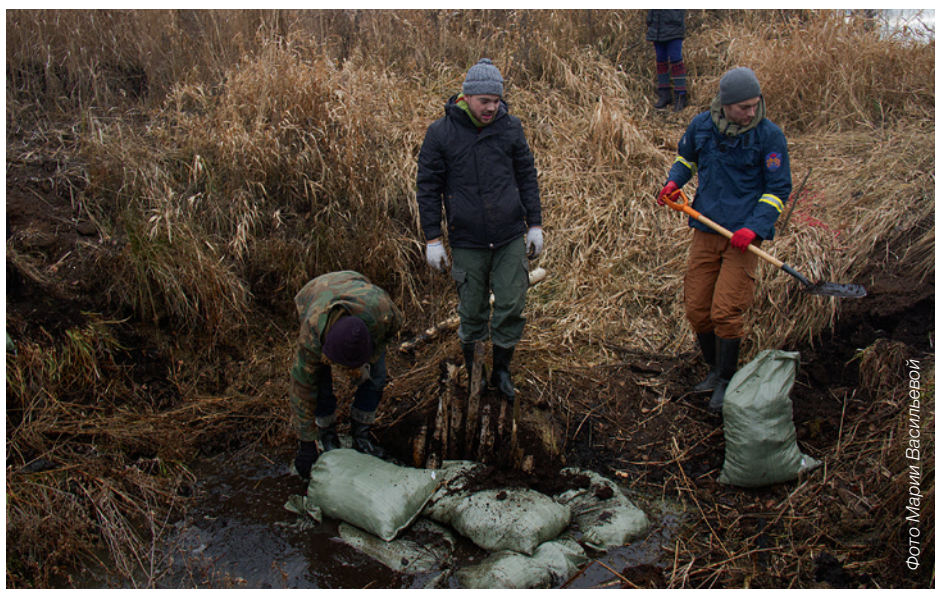
Рис. 28. Создание временной земляной плотины на трубопребезде (обводнение, создание места для забора воды пожарной техникой). Тверская область
