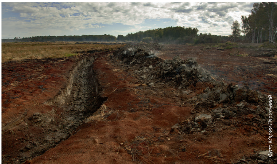
Рис. 35. Локализация траншей. Неправильно: контур не замкнут, отвал сделан вовнутрь. Развитие пожара не остановлено. Бурятия
