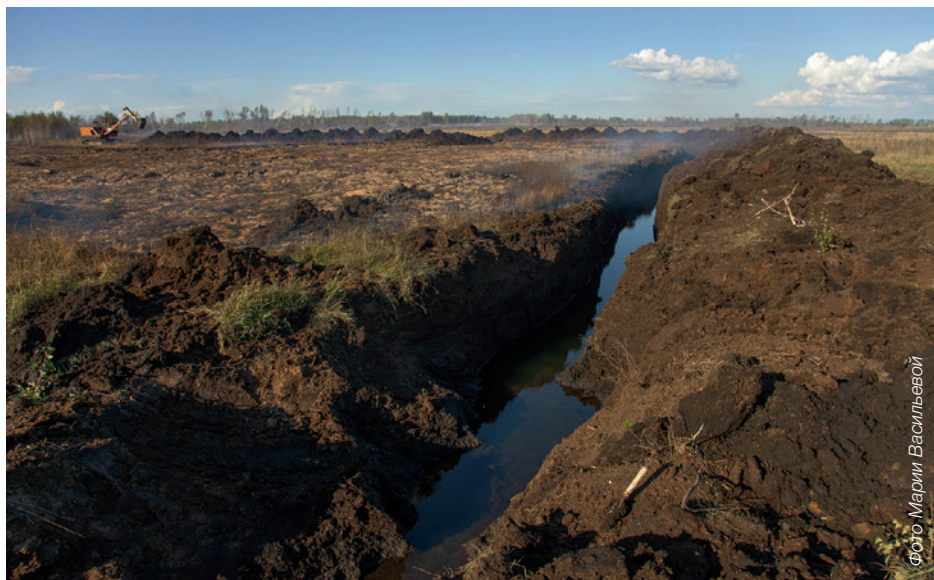
Рис. 20. Правильная локализация очага траншеей (до УГВ, отвал наружу). Бурятия
