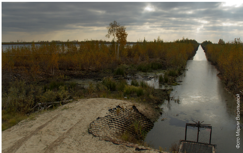
Рис. 26. Удачное обводнение с помощью ГТС (площади залиты, вода в каналах удержана, дорога и само ГТС не размывы). Московская область
