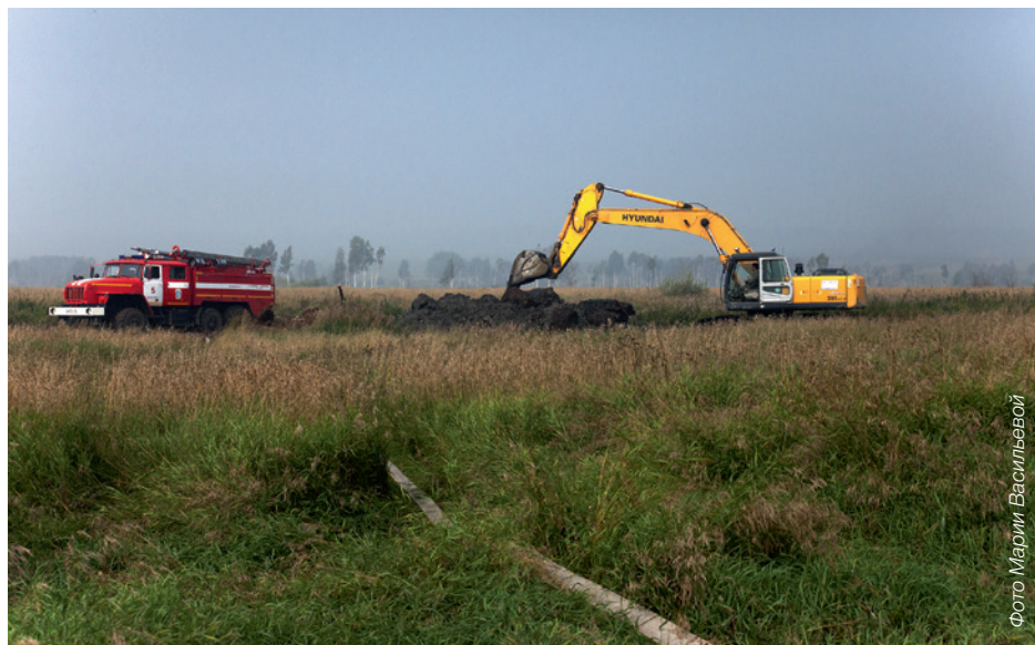
Рис. 21. Создание пирса и углубление места забора воды для АЦ экскаватором. Иркутская область
